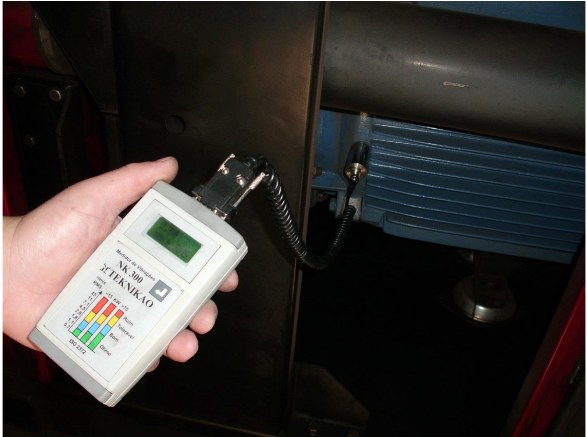
Figura 31. Medição 2 de vibração radial do motor Fonte: Autoria própria
