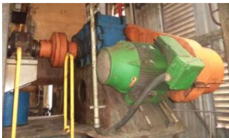
Figura 24 – Motor elétrico do digestor contínuo.
