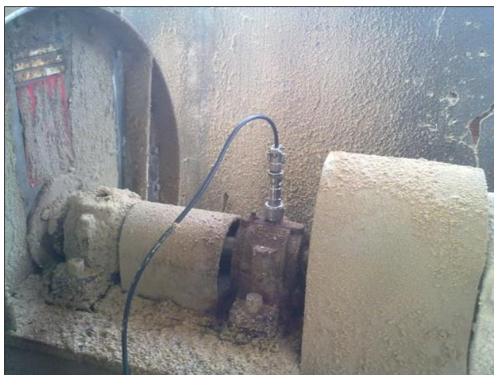
Figura 6.7 - Colocação do acelerómetro no ponto P3 para medição das vibrações.
