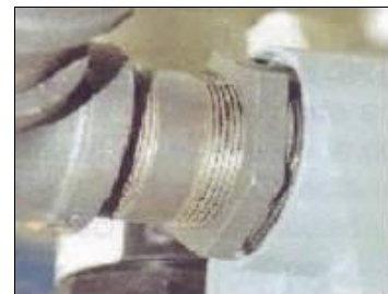
d) Fugas em roscas
