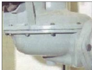
c) Fugas entre uniões
