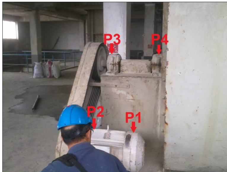
Figura 6.27 - Equipamento: Ventilador V361A com indicação dos pontos de medida.
