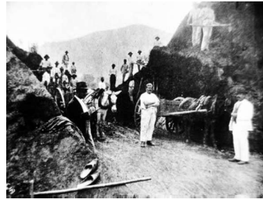
Figura 2 - Início da construção da estrada ligando Santa Leopoldina a Santa Teresa - 1917 Fonte: Família Vervloet.
